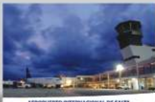
AEROPUERTO INTERNACIONAL DE SALTÁ
